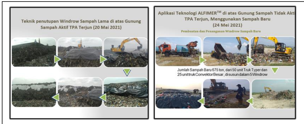
Gambar 6 : Teknik Penutupan Windrow Sampah Lama dan sampah baru
